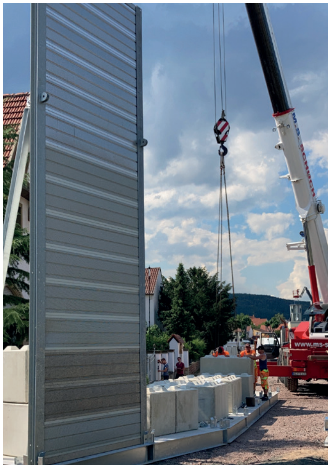
Aufbau einer temporären Schallschutzwand in Bad Dürkheim, um Anwohner während der Umbauphase der Therme zu entlasten
