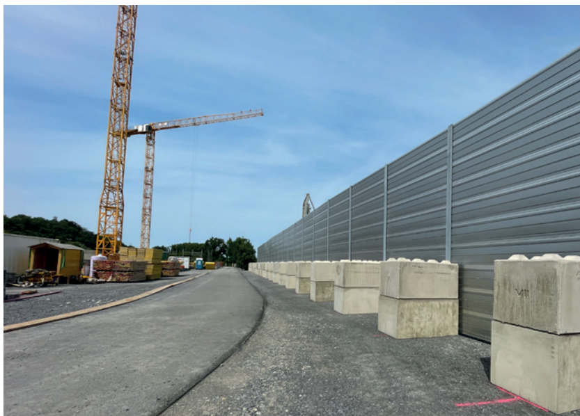
Einhausung Baumaßnahme LIDL-Zentrallager in Kirchheim
