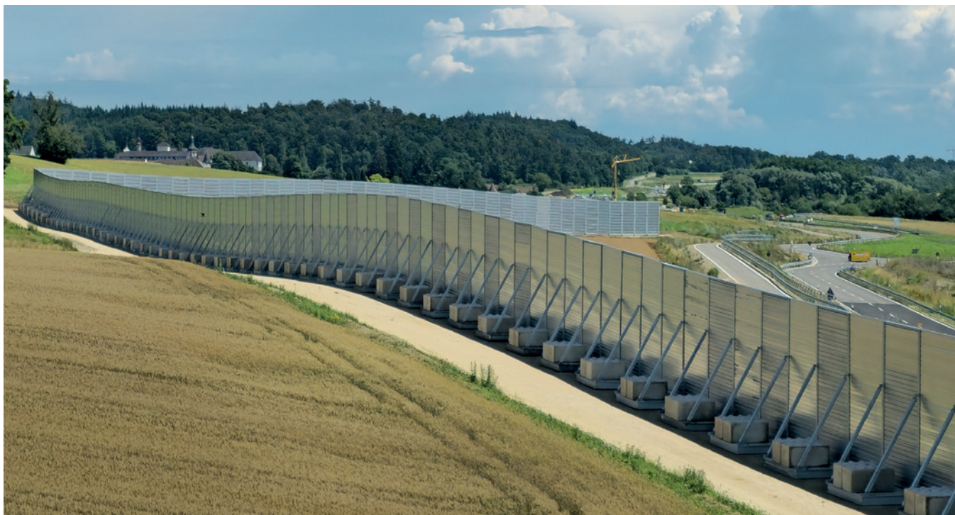
Baumaßnahme Röhrenbergtunnel B 33 zwischen Allensbach und Konstanz
